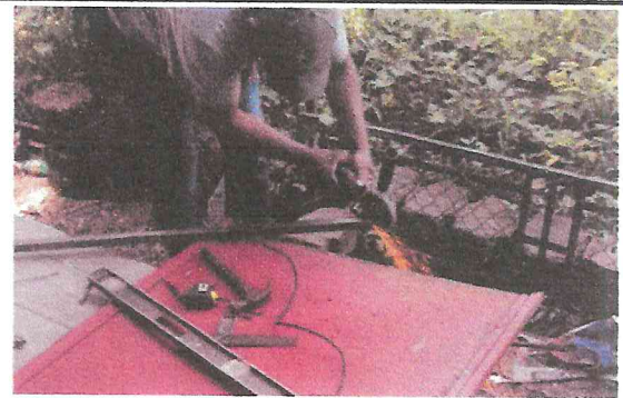
Foto 6: Reparación de puertas
