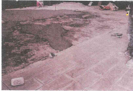
Foto 3: Instalación de piso
