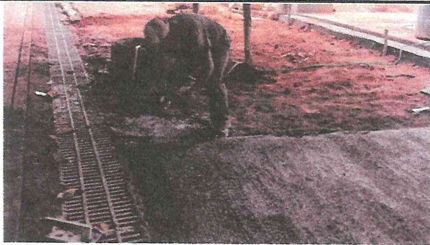
Foto 5: Planchas de concreto
