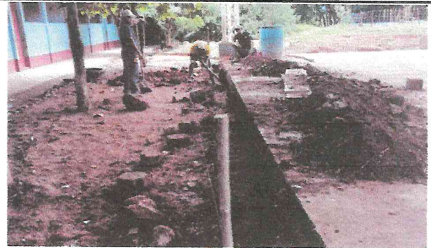
Foto 4: Reparación de banqueta de concreto
